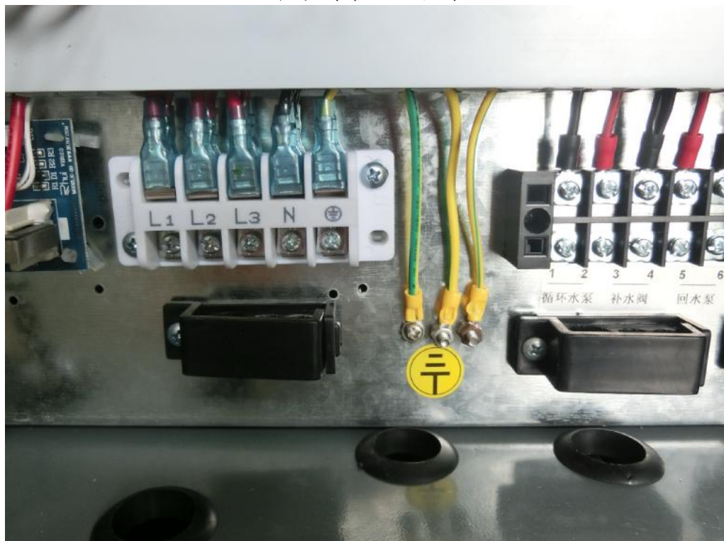
电源线夹紧装置及接地装置
